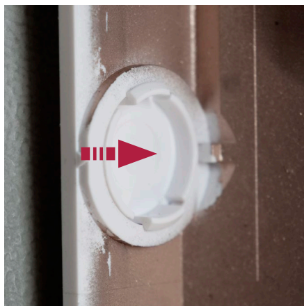
Рис. 22. Установка крышки в случае снятия платы VDI
