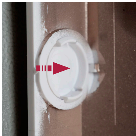
22. attēls. Aizsargvāciņa uzstādīšana gadījumos, kad kāda iemesla dēļ ir jāizņem VIS plate
