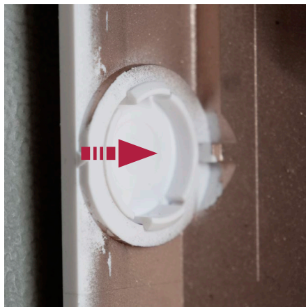
22. ábra: Ha valamilyen okból eltávolította a VDI-kártyát, helyezze be a takarót
