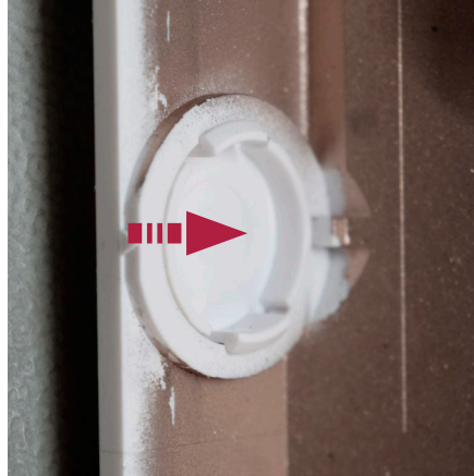
Abbildung 22 Die Abdeckung wird angebracht, wenn die VDI-Karte aus irgendeinem Grund entfernt wurde
