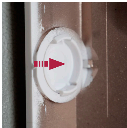
Figura 22 Instalar a tampa se, por algum motivo, a placa VDI tiver sido retirada
