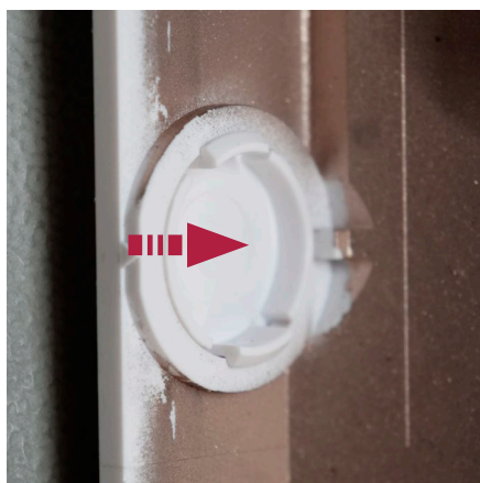
Obrázek č. 22 Instalace záslepky v případě odstranění desky VDI z libovolného důvodu
