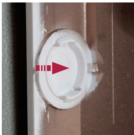
Slika 22 – postavljanje pokrova, ako se iz nekog slučaja, VDI ploča pomiče
