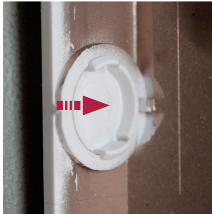
図 22 VDI ボードが何らかの理由で取り外された場合、カバーを取り付ける
